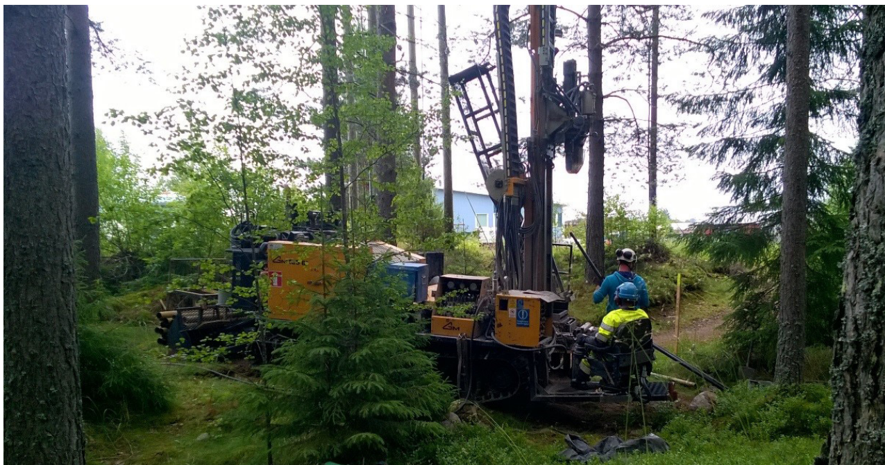
Markborrningar och installation av grundvattenrör görs på hösten.
