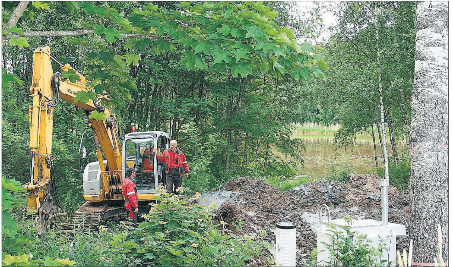
Glenn Nygård och Dan Jakobsson gräver kommunalt avlopp i Maxmo centrum. Arbetet startar mellan kyrkan och församlingshemmet där en pumpstation placerats. De hoppas Maxmoborna har tålamod med grävarbetet, som går över fastigheterna. FOTO: ANNA GAMMELGÅRD
