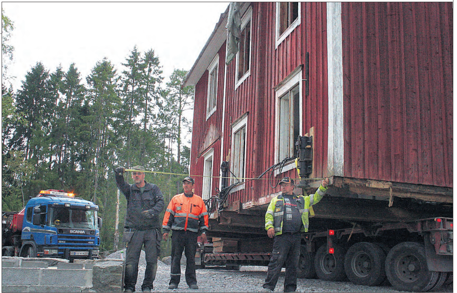
Ansvariga flyttplaneraren Erkki Mäki mäter avståndet mellan huset och grunden och konstaterar att hustransporten står 9 centimeter snett. Jari Knuutila som kör lavettbilen håller i andra ändan av måttbandet, medan Jukka Rantavuori ser på.
